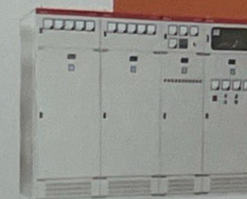
GGD 型低压固定式成套开关设备 Low-voltage fixed switchgear Низковольтные стационарные распределительные устройства
